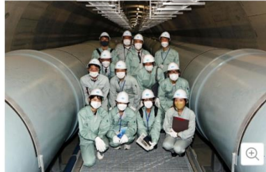
配管廊内を視察する研修参加者
